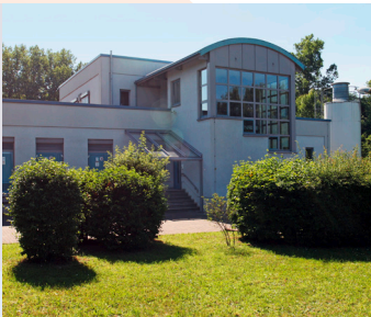
von links: Wasserwerk Papiermühle // Netzleitstelle
